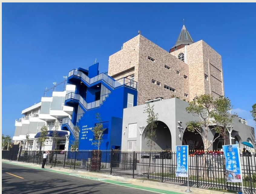
原歷史水景公園橡欣樓
