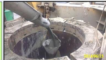
混凝土澆置作業
