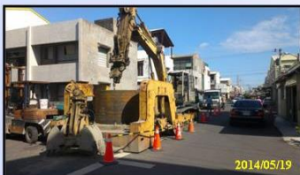
鋼環沉設作業
