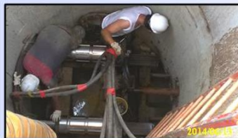
管線推進作業
