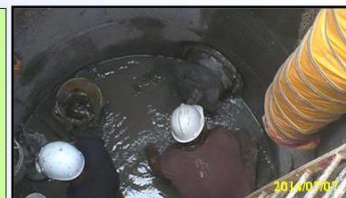
機頭出坑作業
